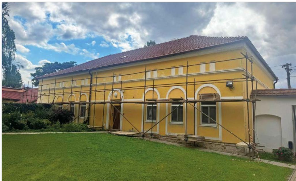
Oprava fasády na farní budově
