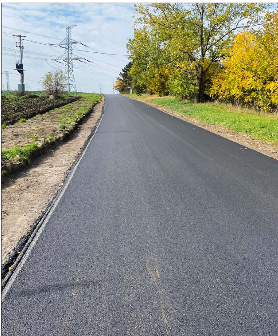
Opravená silnice mezi Telnicí a Otmarovem
