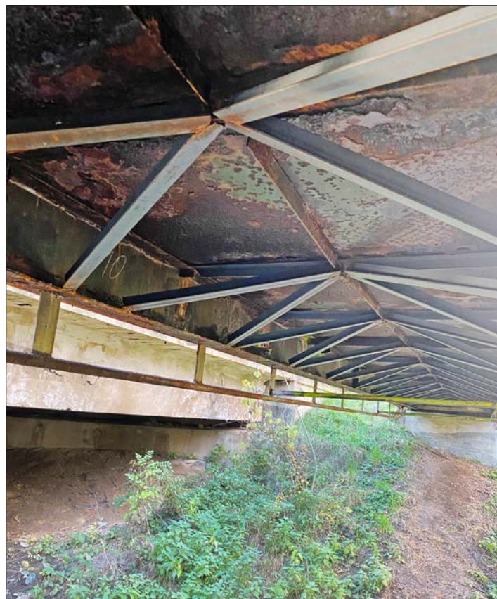
Statické zpevnění železných lávek na Brněnské ulici
