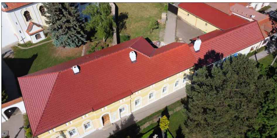
Opravená střecha fary
