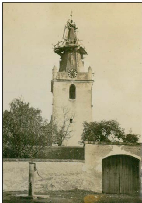
Rok 1922 – opravy kostelní věže
