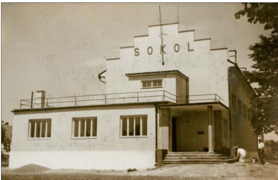
Rok 1932 – téměř dokončená stavba nové sokolovny
