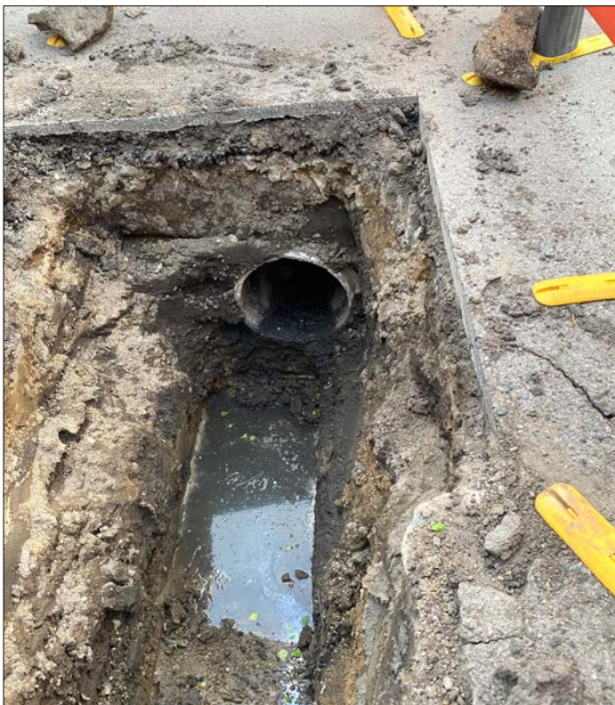
Oprava dešťové kanalizace na Palackého ulici
