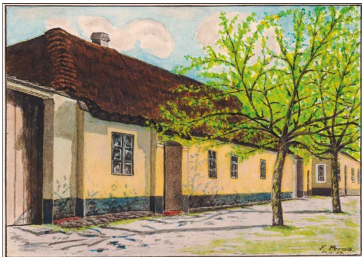
„Dům č. 17/22 – Nejstarší typ selských stavení. Přední stěna přestavěna v roce 1878, stavení zvýšeno roku 1892.“ Dnes zde stojí dům V dědině č. 22.
