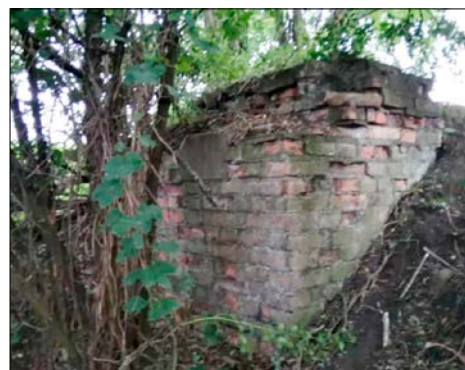
Opěrná zeď mostku
