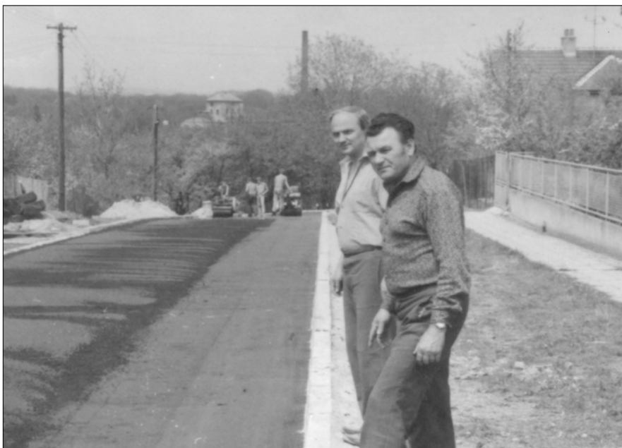
František Vykouřil spolu s Vladimírem Lukášem při asfaltování silnice v ulici Hliníky.
