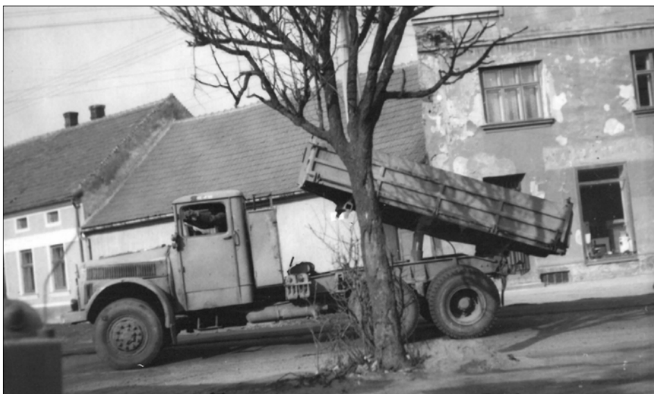
Oprava státní silnice před budoucím MNV Telnice (1977).
