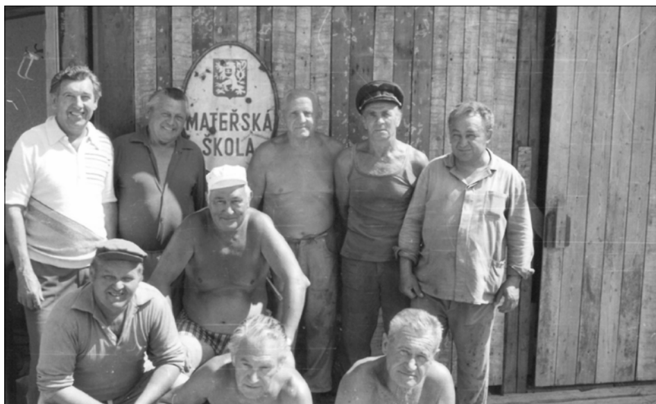
Stavební četa koncem 80. let při stavbě „Jamajky“. Zleva stojí: Vladimír Pustina, Oldřich Konečný, František Král, Emil Matula, Jaroslava Vlasák. Zleva v podřepu: Josef Müller, František Prax, František Tichý, Ondřej Máca
