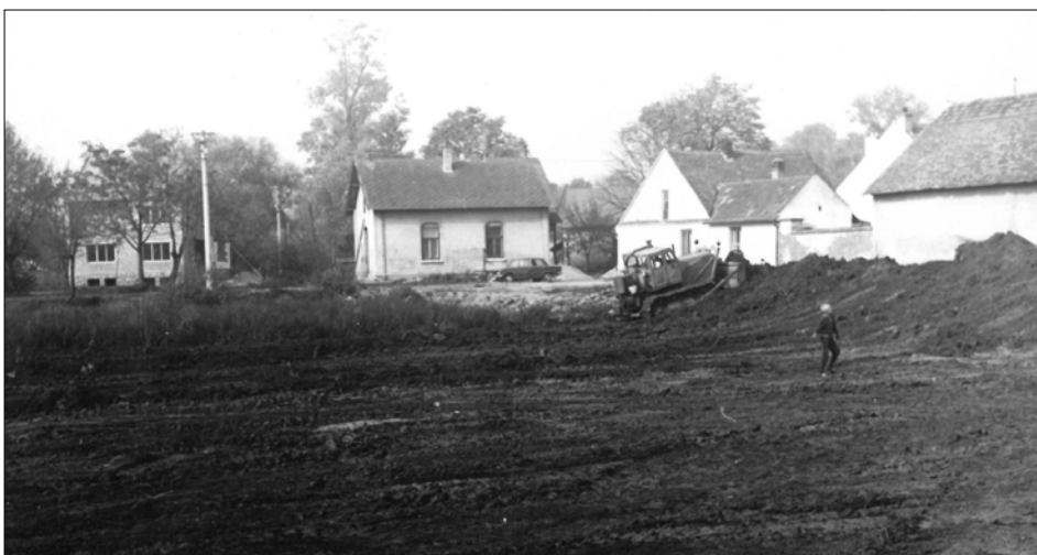
Rekonstrukce rybníka (říjen 1977).
