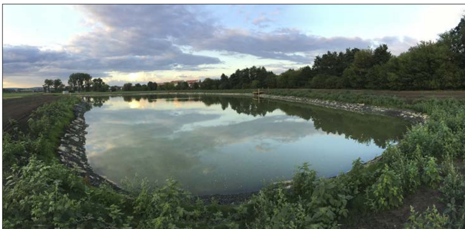
Nová vodní nádrž v Kobylnicích
